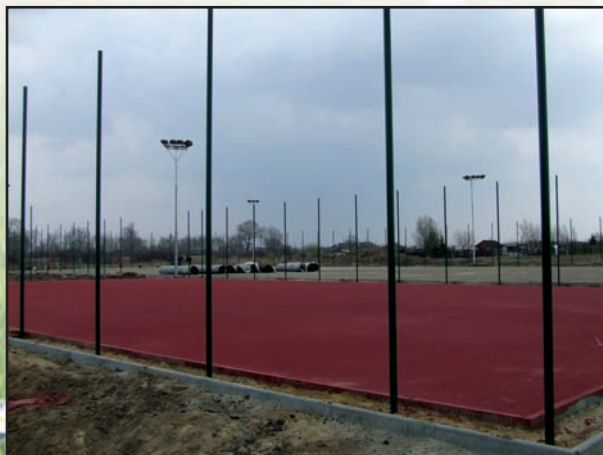
Budowa „Orlika” w Szymanowie
