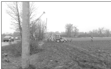
Budowa linii energetycznej i oświetlenie skrzyżowania przed mostem w Szymanowie.
