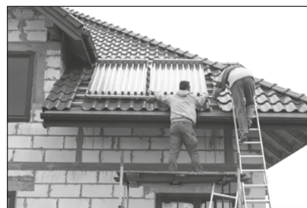
Montaż kolektorów na dachu domu Państwa Traczyk.
